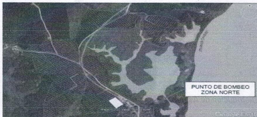
Ubicación Punto de bombeo zona norte
